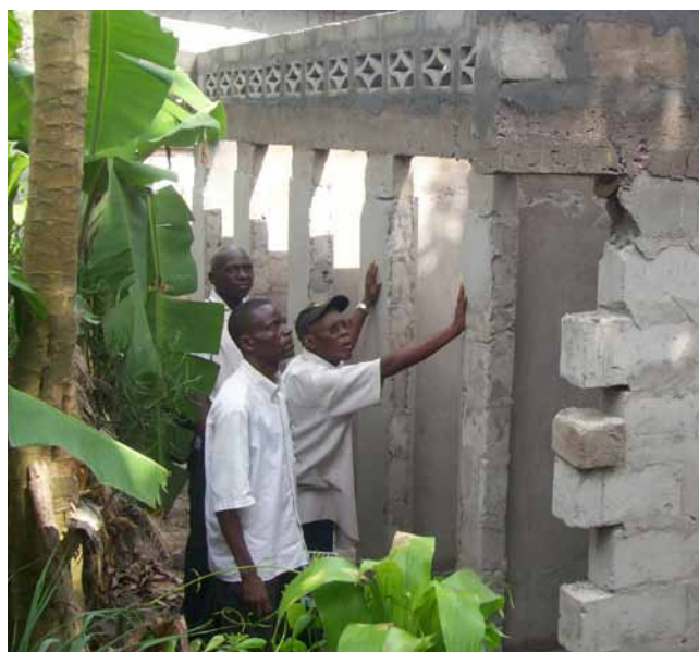
La construction du nouveau Centre de Santé Communautaire à Lemba Imbu, RD du Congo.
